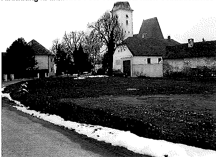
Abbildung 2: aktuelles Foto vom Areal nach Gebäudeabriss
